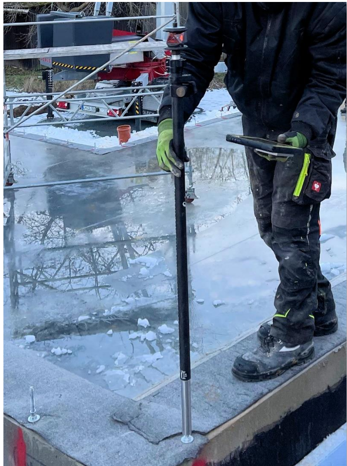
Einstellen der korrekten Höhe der Aufnahmemutter des Stexon-Verbinders
