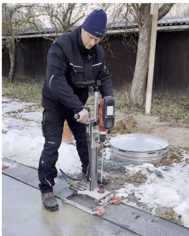
Stexon-Bohrständler mit Prisma in Einmessposition
