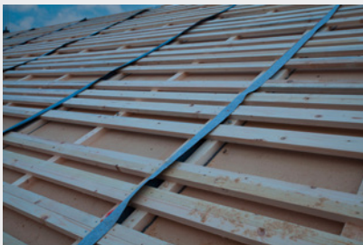
Außenansicht von mit WOOD CONNECTOR WC-BC-50 montierten Dachelementen
