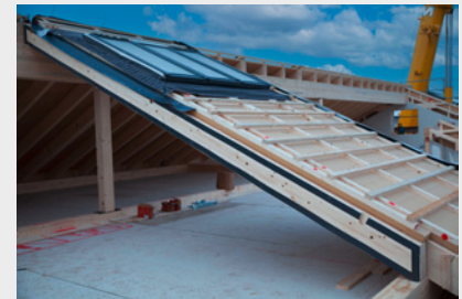
Dachelement mit Frästaschen für den Einsatz mit WOOD CONNECTOR WC-BC-50
