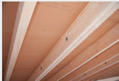
Verbindung der mit WOOD CONNECTOR WC-BC-50 montierten Dachelemente mit Bolzen M16 und Einschlagmuttern
